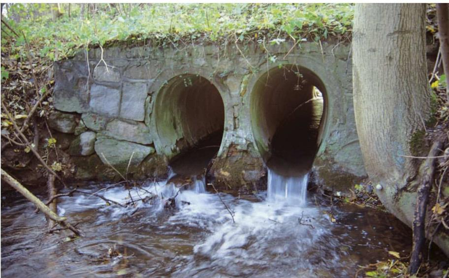
**Abb. 2** Nicht passierbarer Rohrdurchlass im Hellbach, Okt. 1998 (Aufn.: M. KRAPPE).
